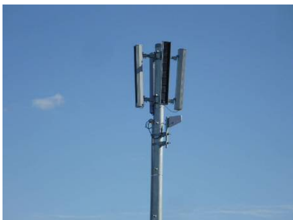
③防災用スリムスピーカー
